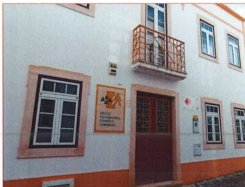
Figura 15 – Instalações da EPA, CIPRL
